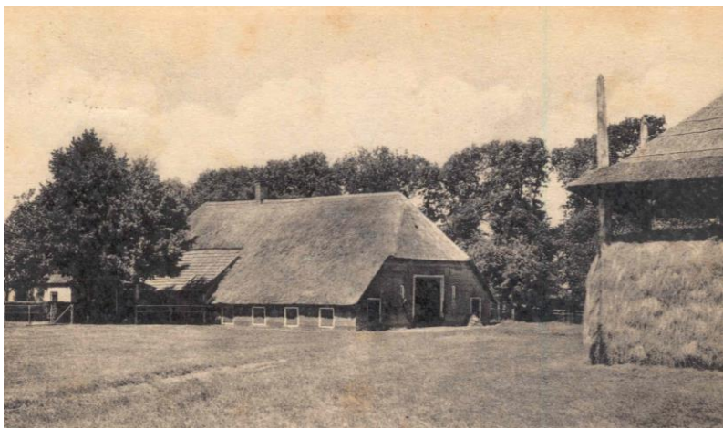
Groot Spijk vlakbij 'zee' voor de Tweede Wereldoorlog. Dit erf bestond al rond 1400.
